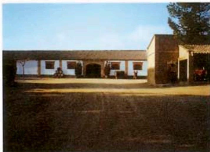
Vista de la bodega de la finca.
