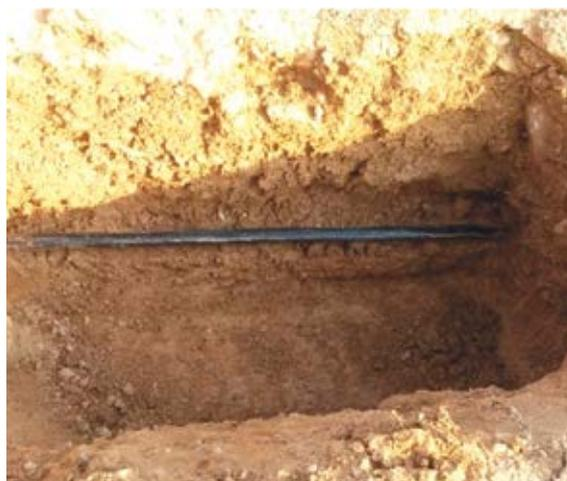
**Foto 7.** Tubería de riego subterráneo.
